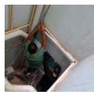
Imagen11. Acomodo de cables y cierre de canaletas.
